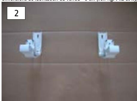
Définir les positions des supports muraux sur le support de montage, marquer les emplacements, puis fixer les supports (ce faisant, tenir compte des conseils de confection et des forces d'extraction indiquées par le fabricant ainsi que des écarts par rapport au bord du support de montage).
