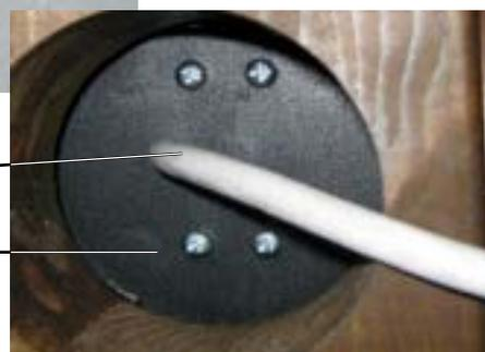
Mettez le connecteur (5.5) en place au niveau de l'axe poussé. Fixez le connecteur à l'aide des vis 3,9 x 13 (5.6).
